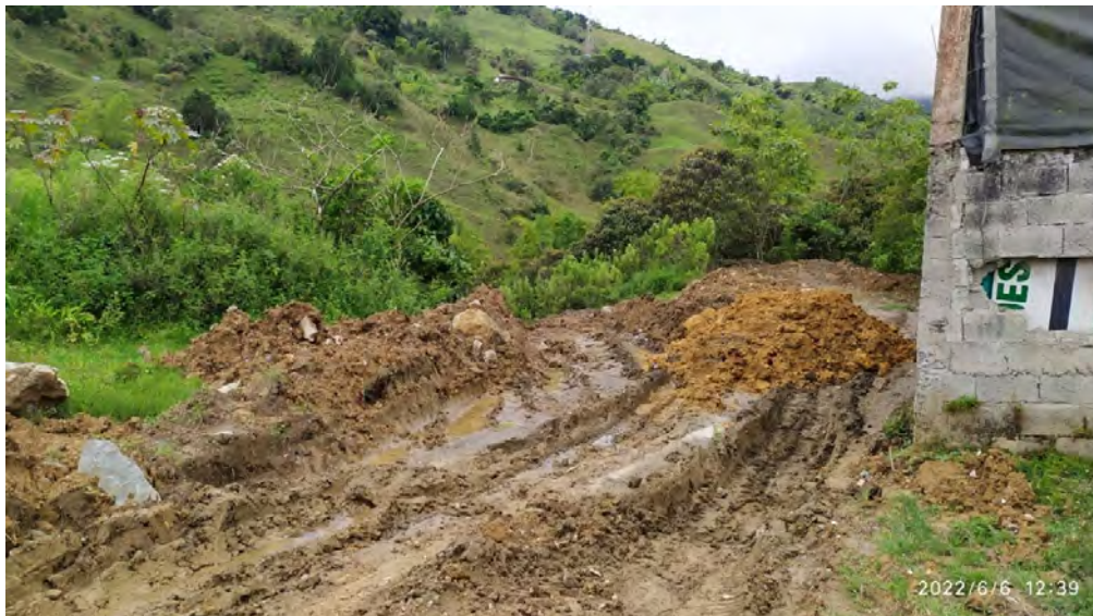
Figuras 4. Punto actual de descarga de escombros con un estado de vía deteriorado
