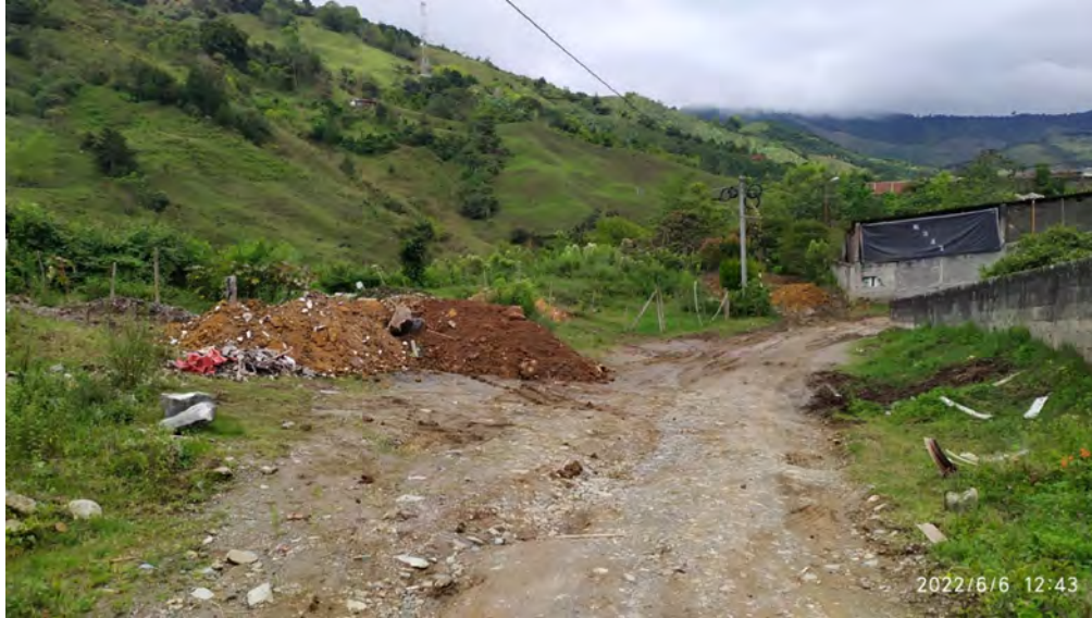
Figuras 3. Vista general de los puntos de disposición de escombros en el Municipio de Pácora, Caldas
