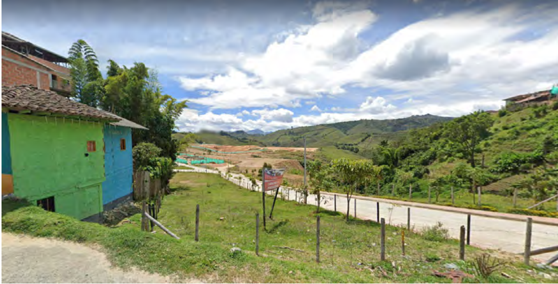
Figuras 7. Vista general del predio privado para disposición de RCD en Aguadas, Caldas
